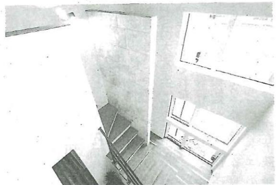
3層ガラスなどで窓の大きさと断熱性能を両立したトータテグループのモデルハウス(広島市佐伯区)
